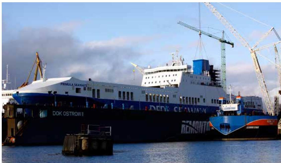
Primula Seaways w doku Remontowej podczas instalacji scrubberów. Fot: Jakub Bogucki
