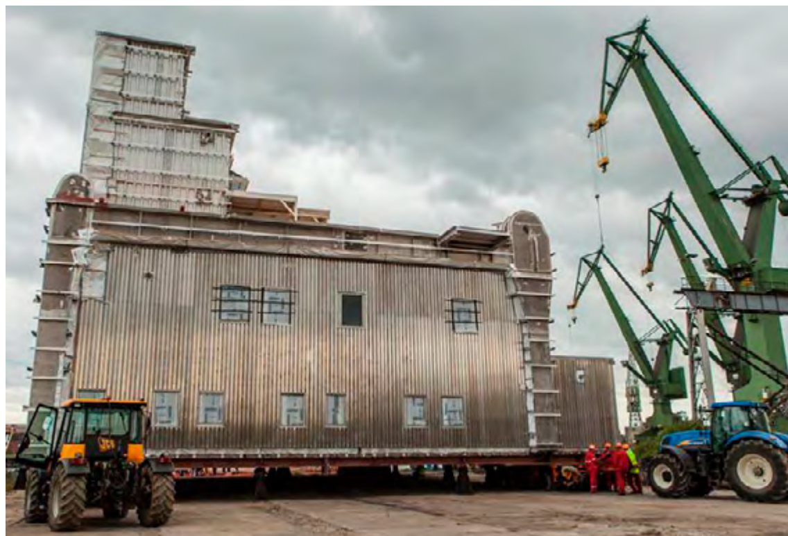
Górna część bloku mieszkalnego platformy Gina Krog. Obok: zestaw schodni. Fot.: Aluship
