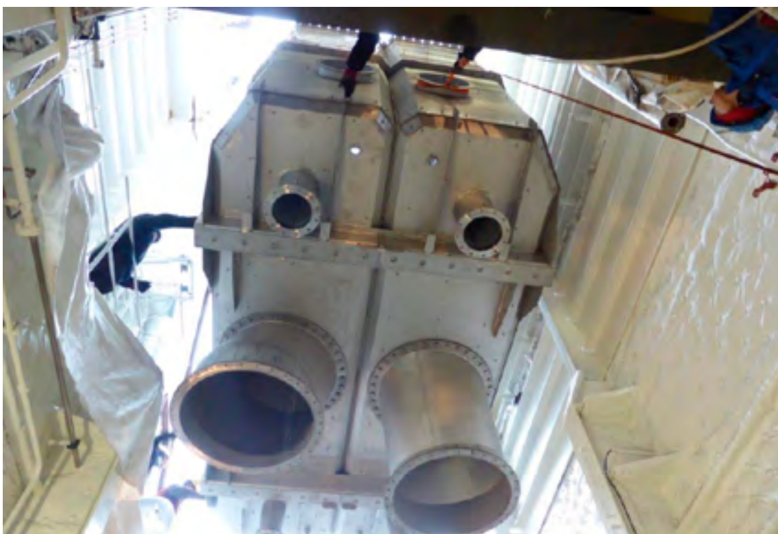
Instalacja scrubbera na promie Ark Dania . Fot.: ME Production
