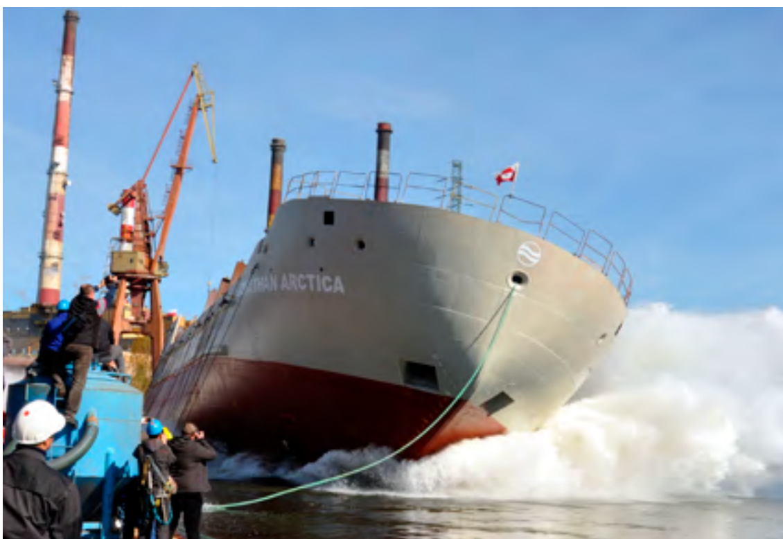
Wodowanie statku B 203/2, 22 kwietnia br. Fot.: G. Landowski
